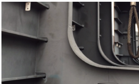
タンカー内部の防錆施工
