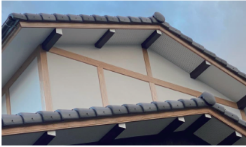
新築から5年経過中
