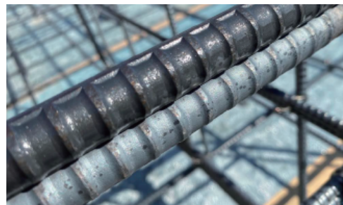
鉄筋構造への防錆施工
