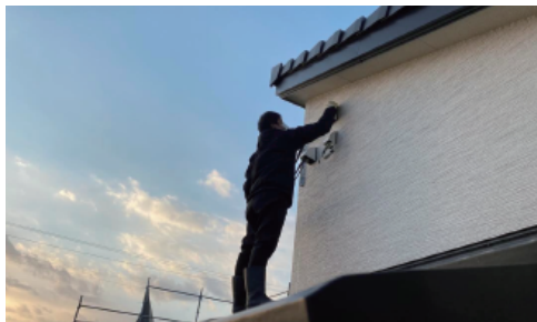
外壁への施工／数十年単位の紫外線劣化防止機能
