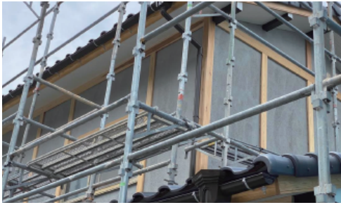
施工中の状況
