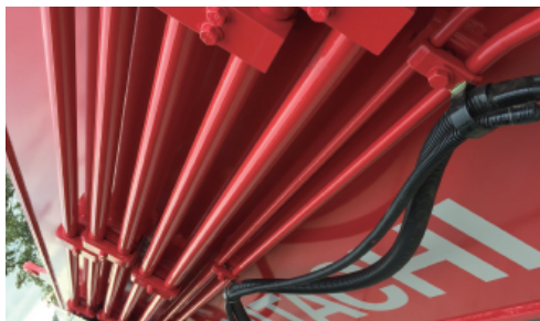
再塗装後8年経過中
