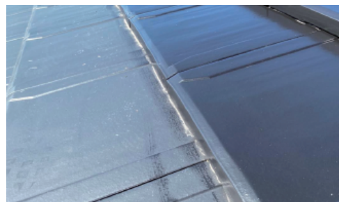
屋根瓦への施工
