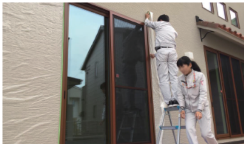
窓枠への施工
