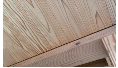
新築から4年経過中の外構設備の木組み
