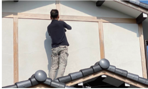
複数回目の施工中
