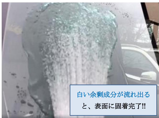
5. 乾燥する直前に高圧洗浄+クロスで流します
