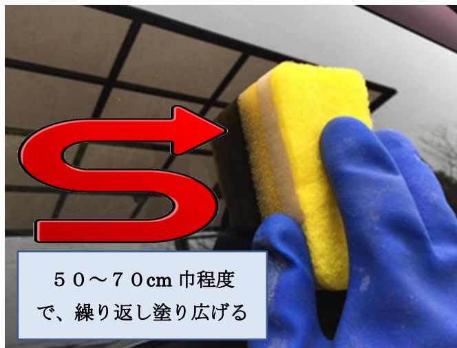
3 スポンジを平行に、下から上に塗布します
